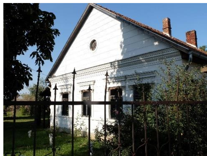
8. Helyi védett épület Népi építészeti emlék – lakóház Fő út 24. szám (138 hrsz) Klasszicista lakóház. Cseréppel fedett, nyeregtetős, falazot orormzatú, sárga színezetű, "L" alaprajzú épület, fatornáccal.
